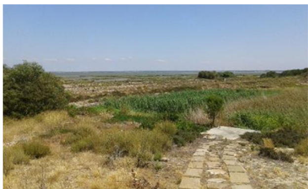
Fotografia 5: Vista geral dos leitos de infiltração de efluente tratado
