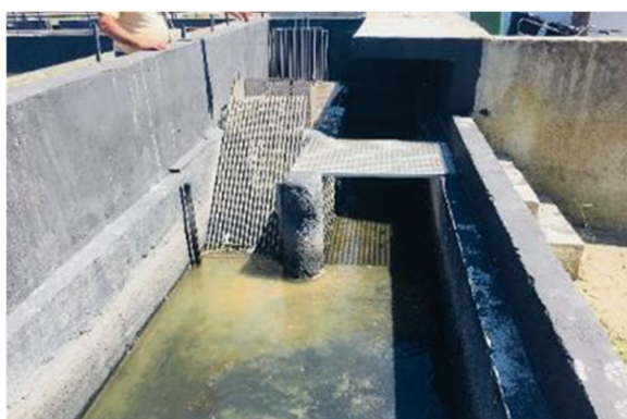
Fotografia 1: Vista geral da obra de entrada
