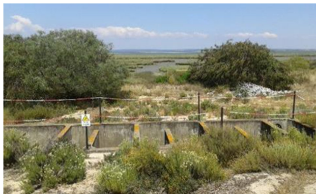
Fotografia 4: Vista geral do tanque de cloragem (desativado)
