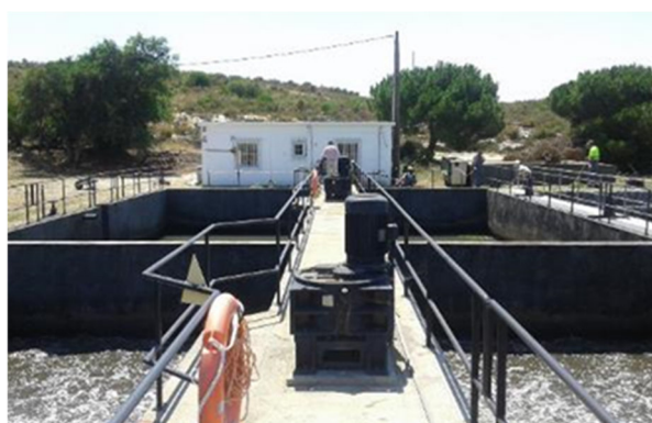
Fotografia 2: Vista geral do tanque de arejamento e edifício de exploração
